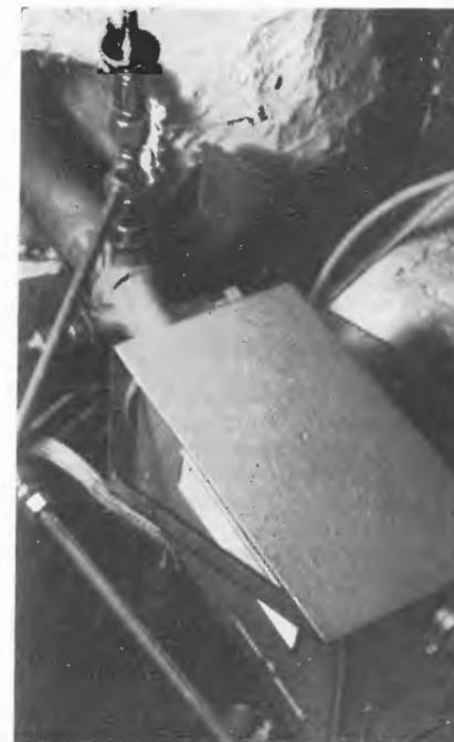
Si distingue perfettamente nella fotografia della telecamera il periscopio di osservazione che penetra attraverso l'isolamento termico del reattore.
