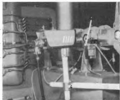
Montaggio di una camera di controllo di bersaglio su un acceleratore Van de Graaff.
